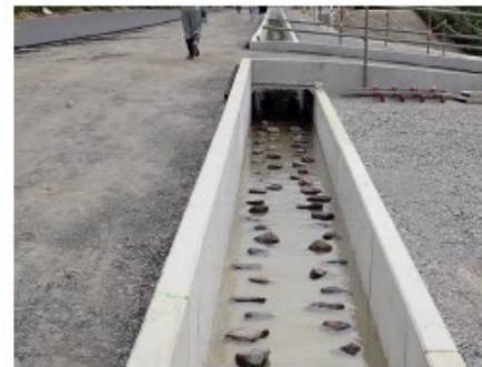
魚道には石を配置し、魚のぼりやすいようにしてあります。
