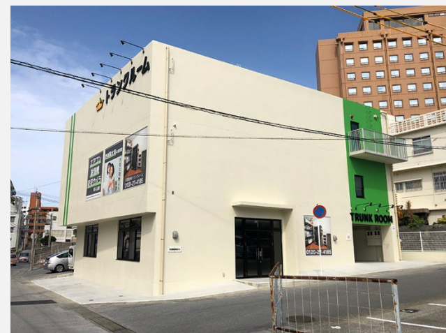
那覇泉崎トランクルーム 内外装工事
